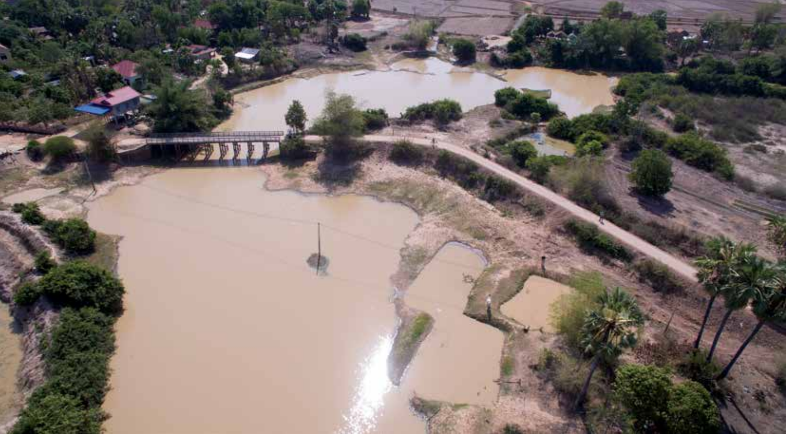
Route surélevée financée par LoCAL dans le district de Rokakiri, Battambang, Cambodge ; photo : Cédric Jancloes © UNCDF/LoCAL
